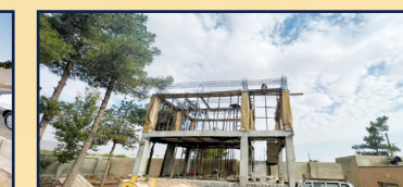
پروژه عمرانی شورای منطقه ۱۰: پروژه ساختن آبنگاه مدیریت بحران - پیرفت فیزیکی: ۱۰۰ درصد - هدف: آبنگاهی و ارائه خدمات مطلوب در زمان وقوع حوادث بحرانی
