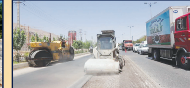
پروژه عمرانی شورای منطقه ۱۰: پروژه ترمیم و آسفالت بزرگراه جندی الهی پیرفت فیزیکی: ۱۰۰ درصد - هدف: بهسازی و بهبود ایمنی سازی مسیر عبور و مرور وسایل نقلیه
