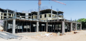
پروژه عمرانی شورای منطقه ۱۰: پروژه ساخت آبنگاه آنت نمانی شماره ۸ شهرک اسفند - پیرفت فیزیکی: ۱۰۰ درصد - هدف: افزایش بارده آبنگاه آنت نمانی و بالا بردن سطح خدمات آبشویی و آنت نمانی در محدوده عملیاتی آبنگاه شماره ۸
