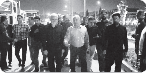
به منظور بررسی و تسریع در روند اجرای پروژه های عمرانی شهرداری، محمدحسن اسدی شهردار شیراز از پروژه لوله گذاری هدایت آب های سطحی محور دروازه قرآن بازدید کرد.
